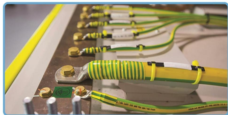
به منظور حفاظت افراد و دستگاهها، اضافه ولتاژهای تولید شده در بدنه که باعث صدمه دیدن دستگاهها و افراد می‌شود، همچنین ولتاژهای بسیار زیاد و خطرناک ناشی از برخورد صاعقه با دکلهای مخابراتی را باید در جایی خنثی نمائیم. به همین منظور استفاده از سیستم ارت و حفاظت از تجهیزات بسیار لازم و ضروری است؛ بعلاوه با افزایش استفاده از سیستم‌های دیجیتالی و حساس، لزوم بازنگری در طراحی، نصب و نگهداری سیستم‌های حفاظتی گراندینگ وجود دارد.
